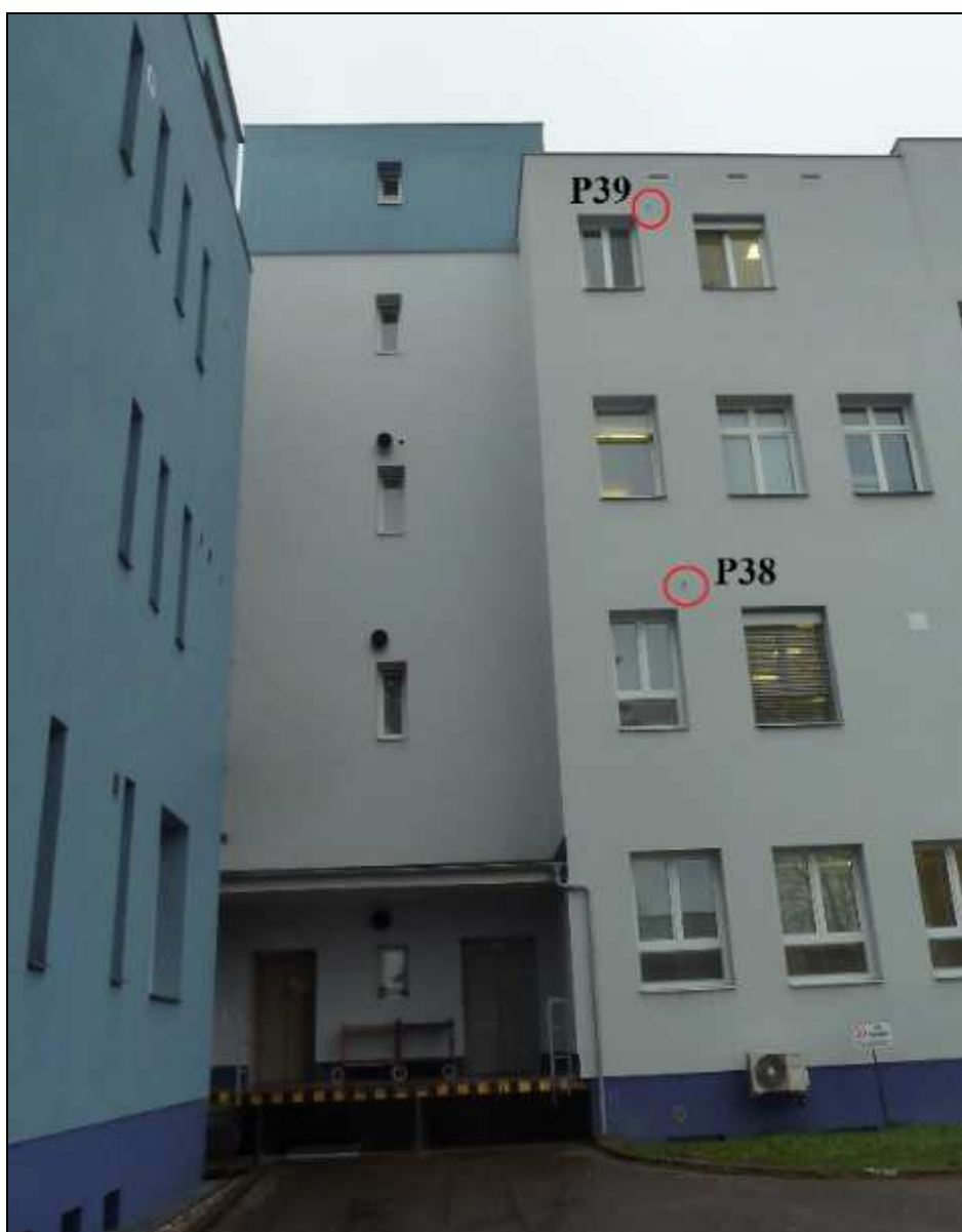
Obr. 4 Odřuky medicinálních plynů od operačních sálů
